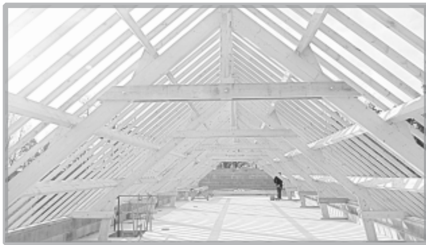
Charpente de la partie monastique du bâtiment
